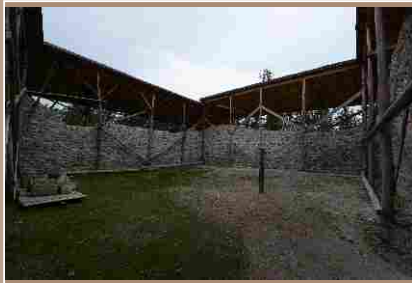
Západná stena veže po obnove
